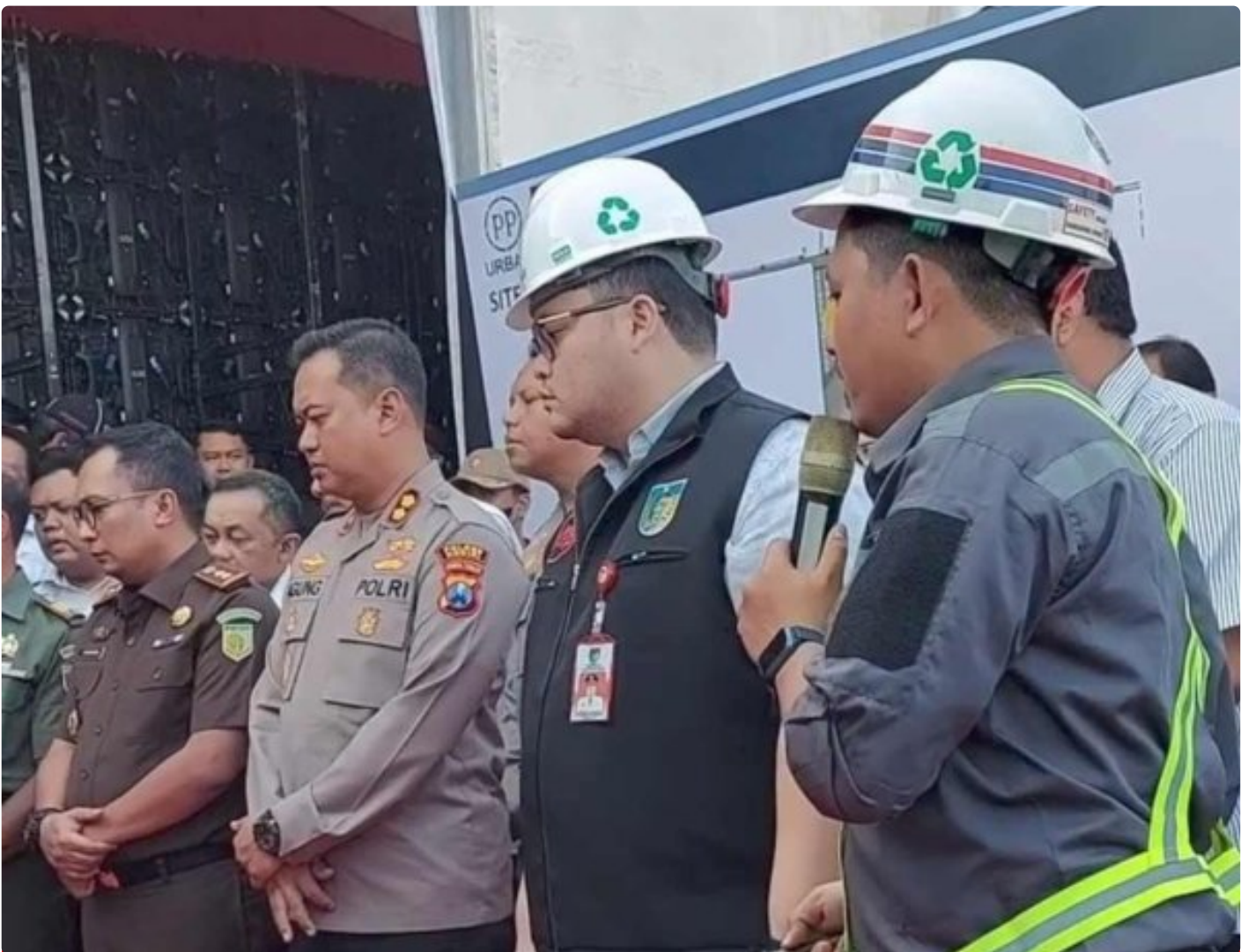
Mas Dhito lakukan ground breaking pembangunan stadion Kabupaten Kediri.
